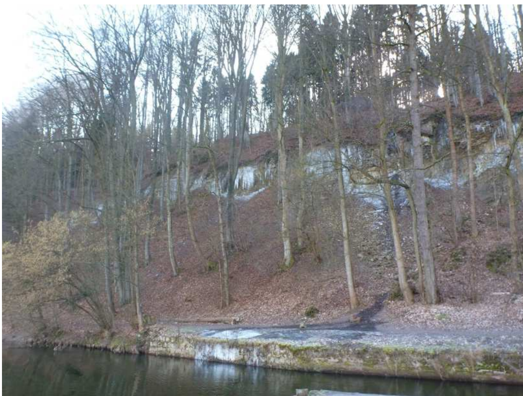
Odstranění vegetace, lokální kotvení a instalace výstraž. cedulí v patě svahu.
